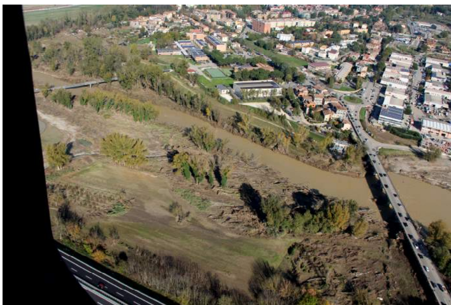
Vista aerea del tratto di Fiume Paglia compreso tra l'area dei laghetti ed il Ponte dell'Adunata in Comune di Orvieto, dopo l'evento alluvionale del novembre 2012.
